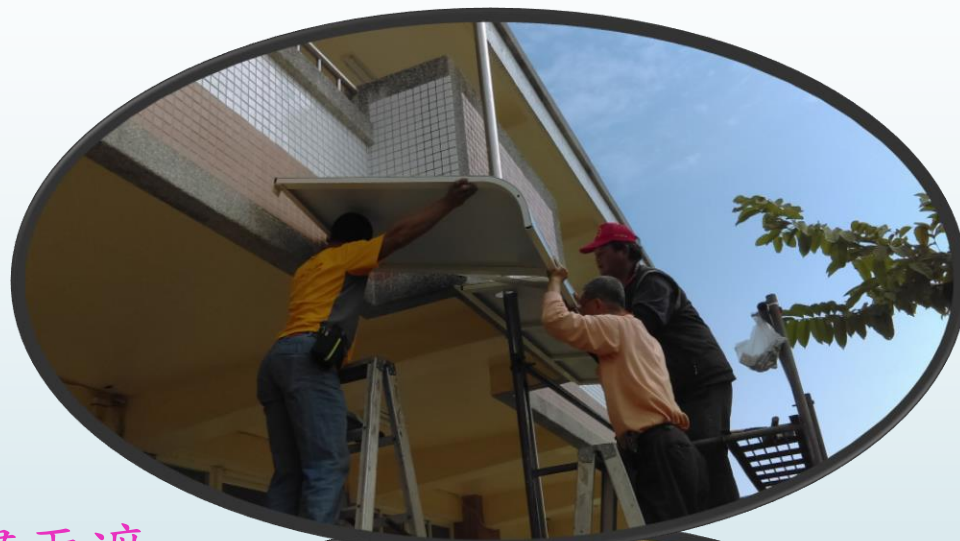
安裝一樓雨遮
