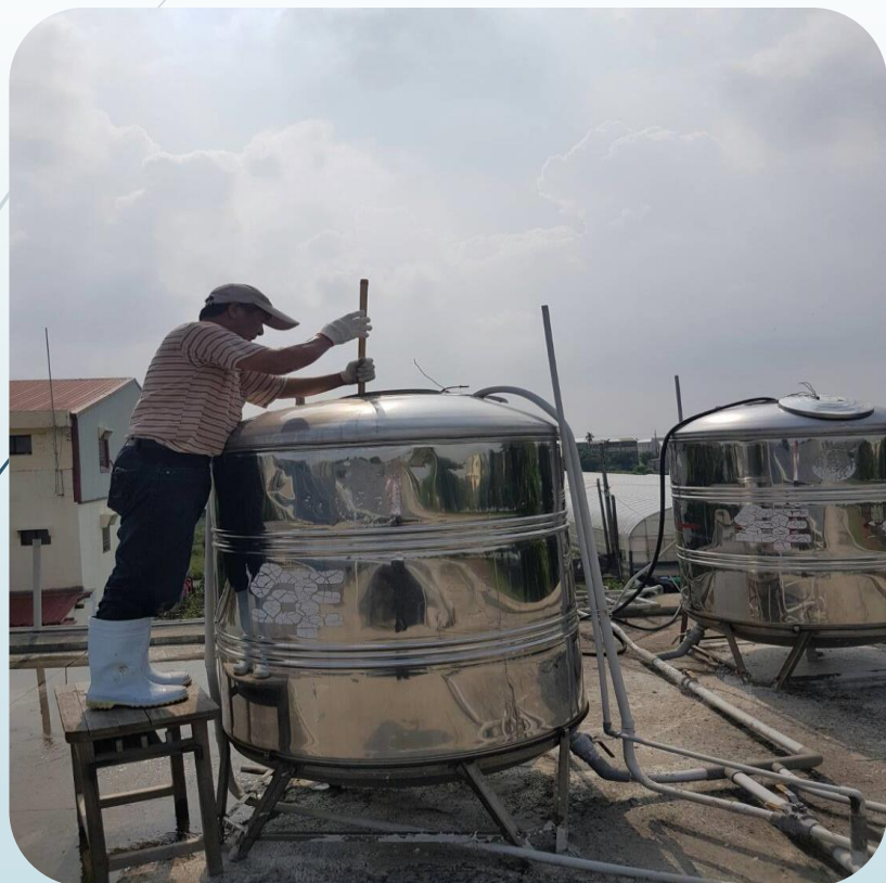
工人清洗水塔
